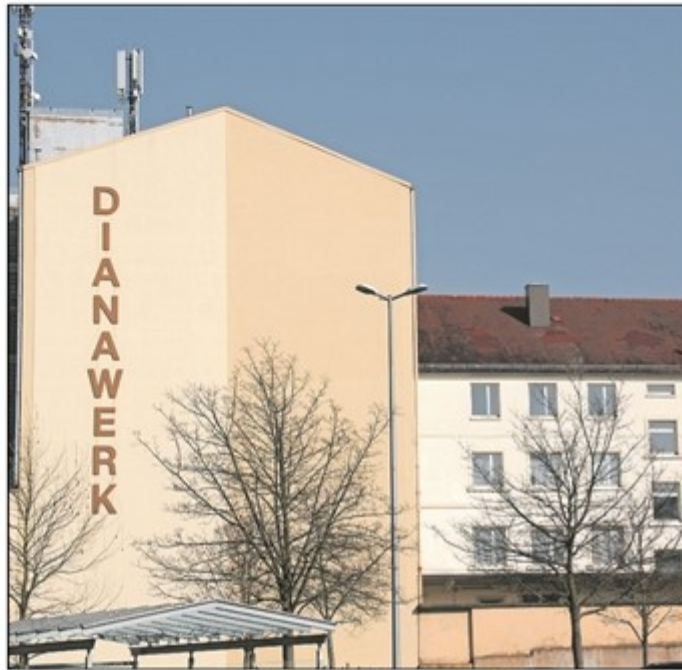
Seit 2014 im Dornröschenschlaf: Jetzt soll das alte Diana-Werk mit Wohnungen wiederbelebt werden. Foto: av
